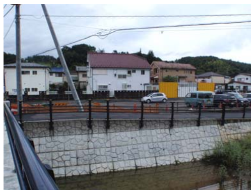
転落防止柵設置状況
