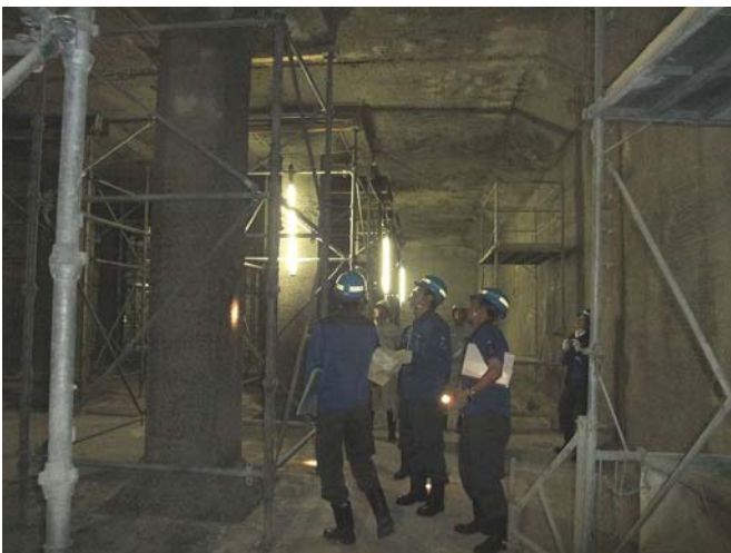
工事現場の現地監査
