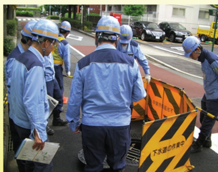
工事監査の様子
