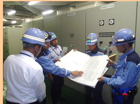
工事監査の様子
