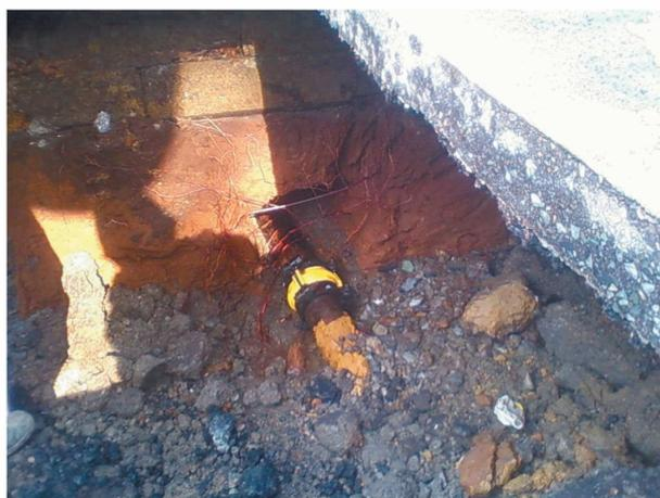
(漏水事故による配水小管の漏水状況及び修理後の状況)
