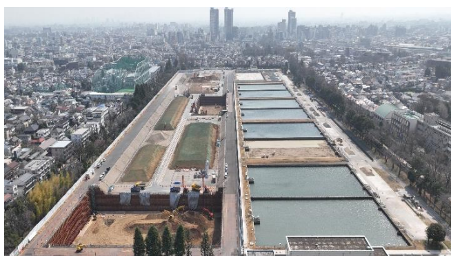
工事中（土留及び土工事）
