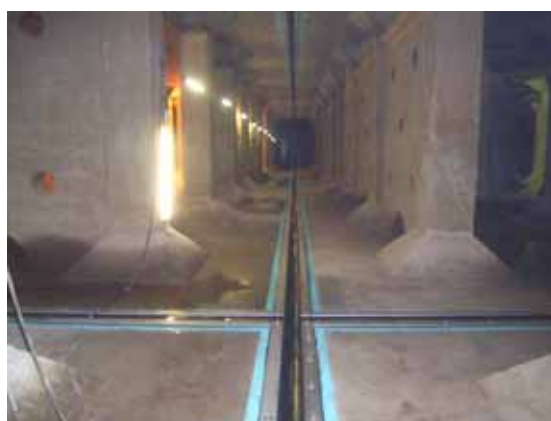
配水池の内部
