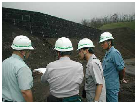
工事現場での実地監査
