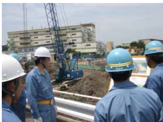
工事現場の实地監査
