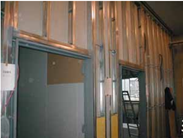
施工中の間仕切壁
