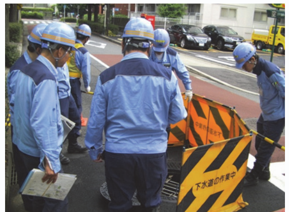
工事監査の様子
