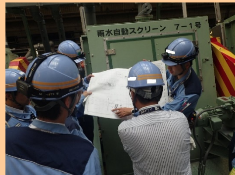
工事監査の様子
