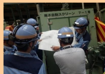
工事監査の様子
