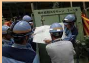
工事監査の様子
