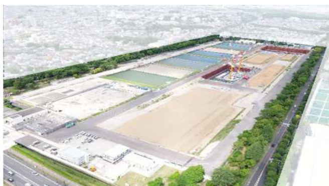
【図1 境浄水場の再構築】
