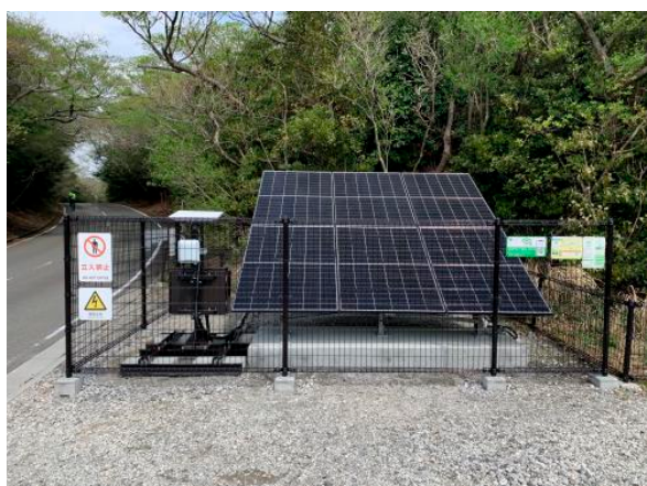
(図 4) 大島町が設置した太陽光を利用したサテライト通信スポット
