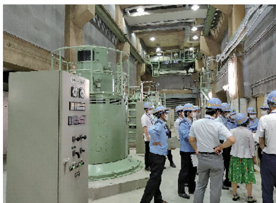
錢瓶町ポンプ所（現場視察の様子） 令和3年7月5日監査人撮影
