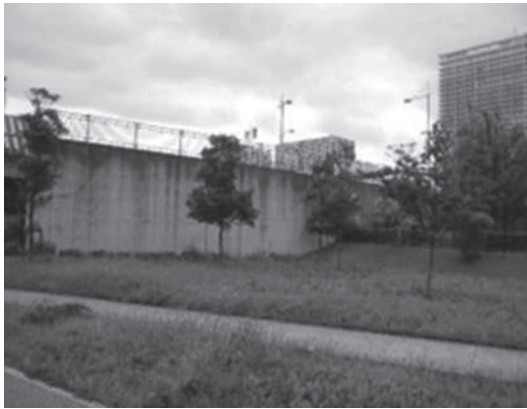
富士見橋たもと付近（監査人撮影）
